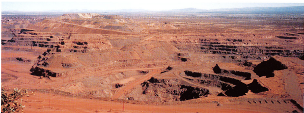
3. 縞状鉄鉱層は27-19億年前の地層に含まれるが、24億年前くらいに集中する。鉱山として稼行されるものは、鉄鉱層が約20億年前の風化作用により更に鉄を濃集したものである。南アフリカ共和国、クルマン鉱山(24億年前)。
