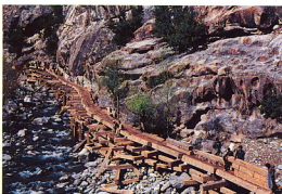
14. インダス河に北方から流入するハンベリ谷の奥で、2,000m以上の標高の森林で伐採された材木をトラック道路まで運び出す木製レール。背後のコヒスタン・パソリスの南縁の花崗岩は変成岩の包有物に富み、風化の差によって抜け落ちた凹穴がよく見える。
