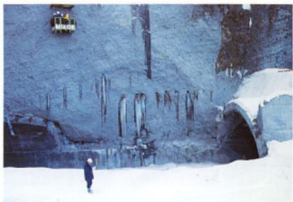
3. 1996年2月10日午前8時10分頃、北海道古平町の国道229号線豊浜トンネルの古平側坑口において、坑口直上の岩盤が剥離、含角螺旋成層火山岩の地層境界部から落下した。偶然にも通りかかった路線バス1台と乗用車が遭難し、事故発生以来8日にして全員の遺体が収容された。崩落箇所は他の国道229号線沿いの地形とほぼ同じように、邊急線の下部が急立し、いわゆるオーバーハング状を呈していた。ユニット境界には湧水が確認される(右写真)。左写真は崩落岩体下部、トンネル直上を撮影。写真右側が古平側、左側が余市側であり、右側にはトンネル巻出し部が見える。
