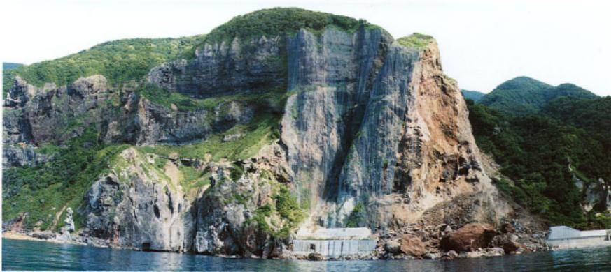
2. 1997年8月25日午後2時30分頃、北海道島牧村の国道229号線第2白糸トンネルの瀬棚町側巻き出しが、約100mにわたって崩壊、高さ約70m、幅約30m、厚さ約10mに及ぶ主に角閃石石英安山岩質水冷破砕岩が下位のシルト層境界から崩落した。急崖の上方はほぼ平坦な面を形成し、さらに、写真からもよく見えるように海岸線とほぼ直交するようにガリー浸食による溝が多く形成されている。
