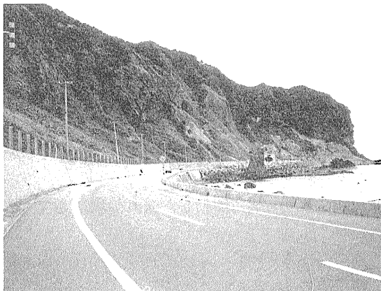
第1白糸トンネル遠景(島牧村側).
