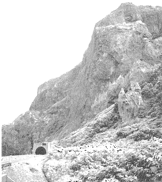
写真1 第2白糸トンネル崩落箇所周辺の崩落前の様子 (平成9年7月15日北海道支所中川主任研究官撮影)。
