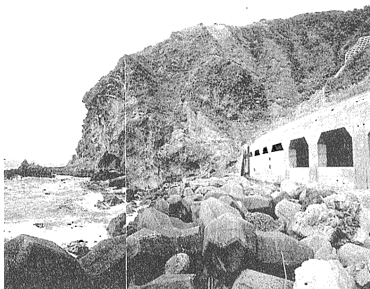
第1白糸トンネル(瀬棚町側).
