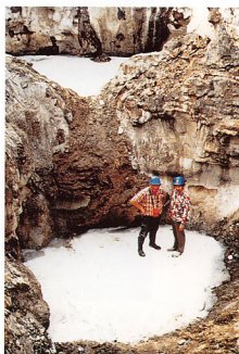
6. 1989年9月に実施された、プール底の噴気孔を密封するためのコンクリート工事。 プール底面のいくつかの噴出口からの漏水を塞ぐための工事である。底面は 600 \text{ m}^3 の巨礫と岩石によって埋められた。その表面近くは安定した作業ができる ようサイズの小さいもので充填され、その上に軽量金網で補強されたコンクリ ート層が張られプールの側壁と密着された。北東部の噴気孔すべてと南西部の 一部は完全に密封されたが、南西部の浅部噴気孔は密封されなかった。それは 圧力が上がり水蒸気爆発を制御できなくなる危険性を軽減させるためである。
