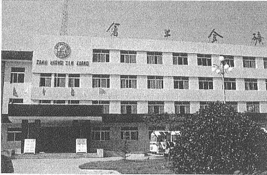
写真8 倉上鉱山事務所
