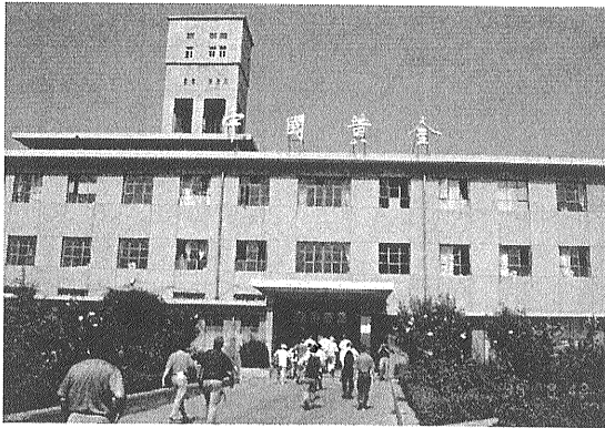
写真6 三山島鉱山の中央事務所
