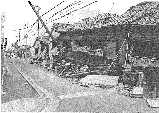
写真3 長田区の木造住宅の被害。軒並み1階部分が崩壊していた。
