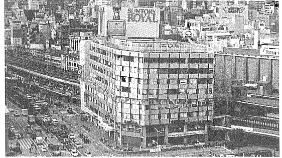
写真8 中間層が崩壊した鉄骨鉄筋コンクリート造建物。一部鉄筋コンクリート造。
