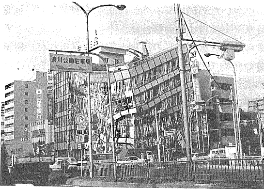
写真4 兵庫区にある鉄骨鉄筋コンクリート造建物が全層にわたり崩壊していた。
