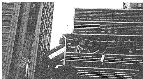
写真13 市役所の新棟と旧棟を結ぶ連絡橋が落下。
