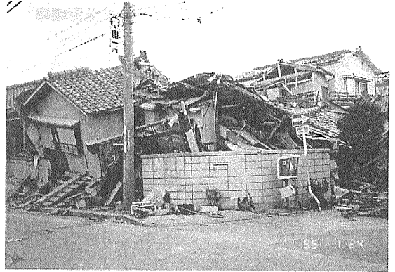
写真19 神戸市東灘区の木造住宅の被害。
