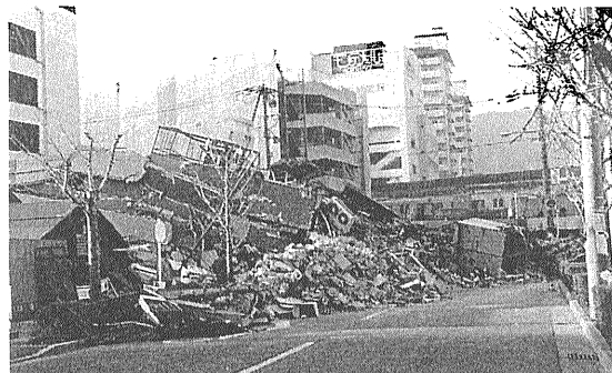
写真23 全層が積み重なるように崩壊した鉄筋コンクリート造建物.
