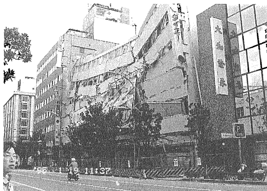
写真9 全層が崩壊した鉄筋コンクリート造建物。
