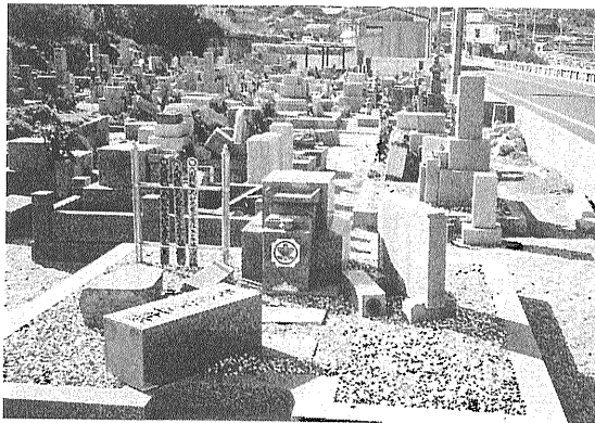
写真4 墓誌と墓石の転倒。墓石はかなり遠くに転倒しているが、墓石の右側の墓誌は倒れていない(EZ-2)。
