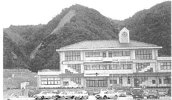
写真7 北淡町野島小学校裏の山に見られる斜面崩落。
