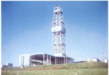
中部ヨーロッパ大陸の基盤岩の構造や特性を調べることを目的として、KTB（ドイツ大陸超深度掘削計画）のメインホールは1990年秋に掘削を開始し、1994年秋深度9,101mで掘削終了した。1981年の計画立案から事前調査、パイロットホール掘削、そしてメインホール掘削とこの間、14ヶ国から270名を越える研究者が参加した。掘削技術の上でも、世界最初の垂直掘削システム（本誌、斎藤）や新開発の掘削泥水デハイドリルHT（地質ニュースno.419、浦辺、1989）など新しい挑戦が行われた。現在は地殻深部の実験室として坑井内観測等が実施されている。
