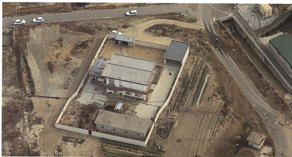
3. 住家のコンクリート堀や、土塁、畑の畝を1.3～1.5 m 右横ずれさせた地震断層。(1月21日、北淡町小倉/江崎灯台から8.1 km地点)
