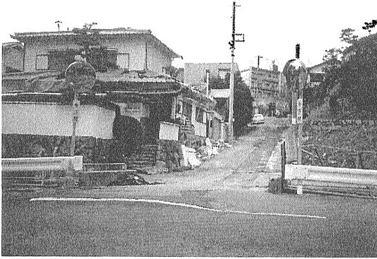
写真3 dタイプ地すべり。坂の途中(自動車の付近)に頭部滑落崖があり、手前の道路が圧縮域となっている(センターラインの付近が隆起している)
