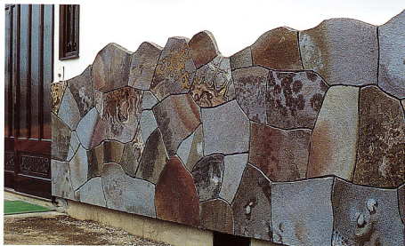
5. 外壁に使われた鉄平石（乱形貼）。節理面に沈澱した酸化物がさまざまな模様を見せる。
