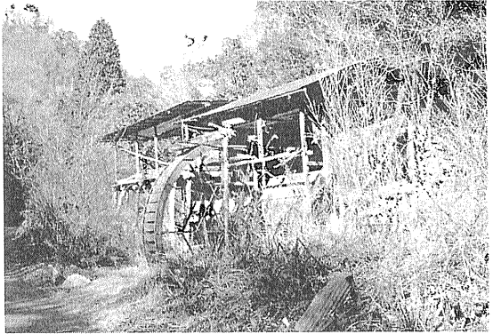
写真12 愛知県猿投山地、かつて水車の力で『そうけい』を粉砕したボールミルの廃屋。
