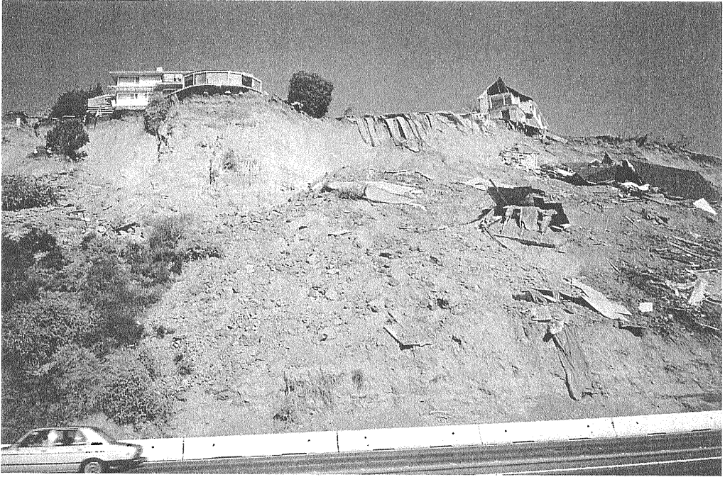
写真1 サンタモニカ地区に発生した崖崩れ。写真の住宅はサンタモニカビーチを眼下に見下ろすいわゆる高級住宅であったが、現在は居住できない状態である。当地では自然は自然のままにという志向があるため、日本で見られる法面保護工事を一般に施していない。
