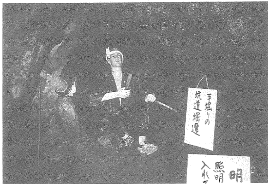
写真2 明治・大正期の「手掘り」。
