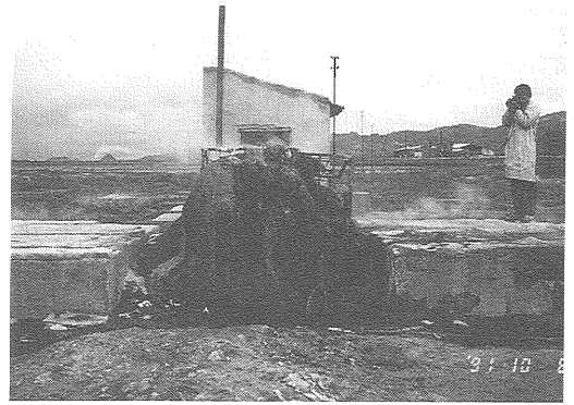
写真5 AF-1号井。口元がスケールによってすっかり覆われてしまっている。
