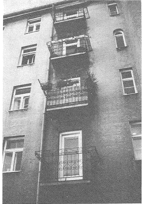
写真3 ナウマン博士旧居の建物の裏側。
