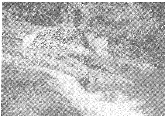
写真 4 砥部町砥部川河床の中央構造線（砥部衝上断層，N70°E・30°N）
