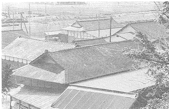
写真1 天然スレートで葺かれた民家の屋根(宮城県雄勝町)
