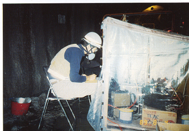
2. 坑内での観測風景(久慈地下石油備蓄基地にて)
