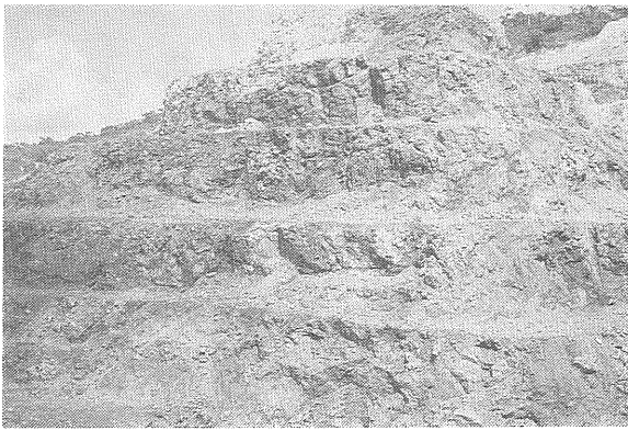
写真 6 酸化帯—硫化帯境界付近 (I) (Monte Negro 鉱体, 口絵写真 2 の左部)。酸化は割れ目に規制されて酸化鉱と硫化鉱が不規則に入り乱れている。
