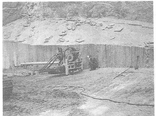
写真7 ツインライナーによる水平掘(すくい)
