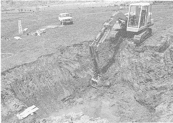
写真5 掘り上がり間近のトレンチ。バックホーのツメ跡で断層は見えない(西側壁面)。
