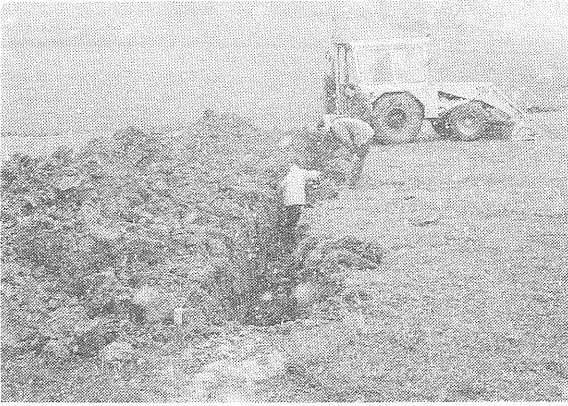
写真2 雪の中でのテストピット掘削。
