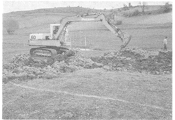
写真3 いよいよ本トレンチの掘削開始。
