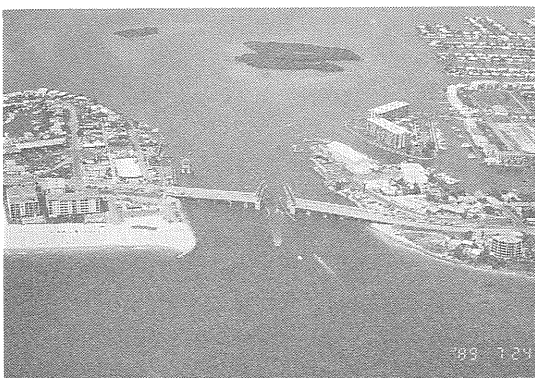
写真4 潮流口 Johns Pass に設けられたハネ橋. 手前側が外洋, 向う側がラグーン. ラグーン内の島は上げ潮デルタの陸化したもの.
