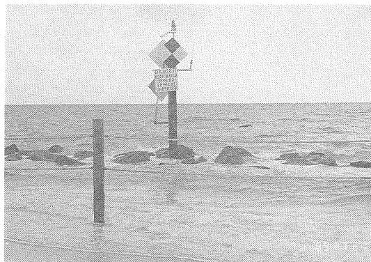
写真7 フロリダ唯一の消波ブロック堤 (breakwater). 天然石を積み上げたもの. Sand Key.
