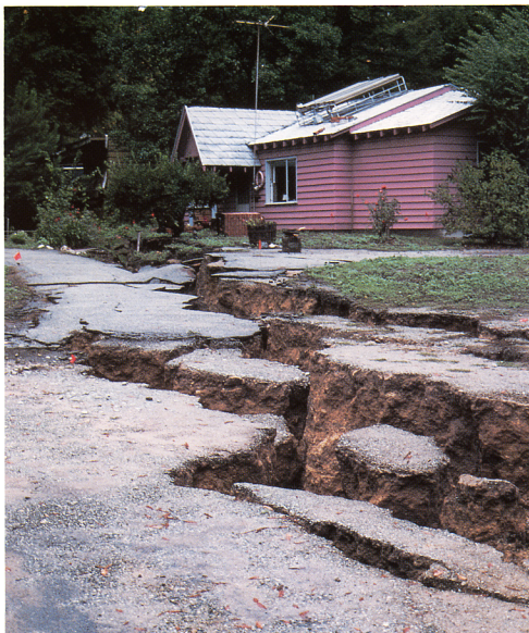
3. サンタクルーズ山地のサンアンドレアス断層に近い Summit Road 付近の地割れ。 (USGS Circular 1045; 写真提供: USGS)
