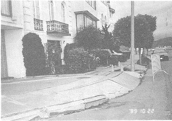
写真1 マリーナ地区の路面には、地下の変状を思わせる亀裂や隆起が見られる（東京大学 地震研究所 伯野元彦による）。
