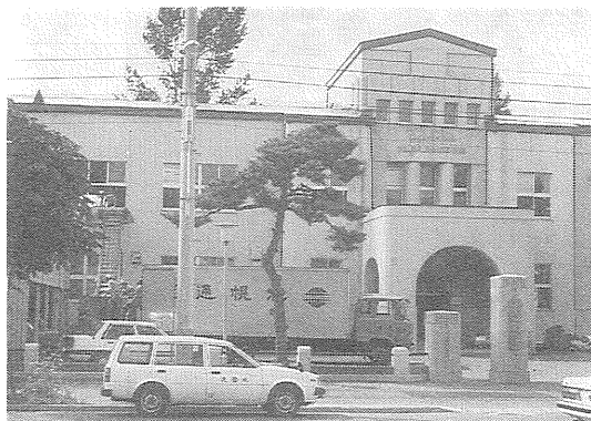
写真1 旧庁舎からの移転作業
