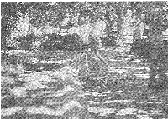
写真6 ホリスター市街。歩道と家の柵が断層で屈曲している。
