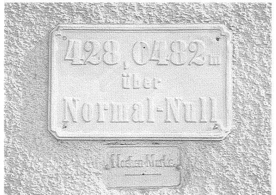
写真5 駅の壁に取り付けてあった水準点(?)。 何と0.2mmまで表示してある。
