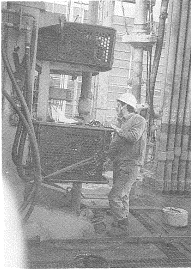
第17図 基礎試錐「仁賀保」での掘削現場 6000mのリグによって青沢層を目指した掘削がおこなわれた。
