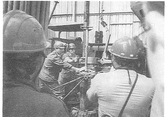
第8図 掘削作業現場
