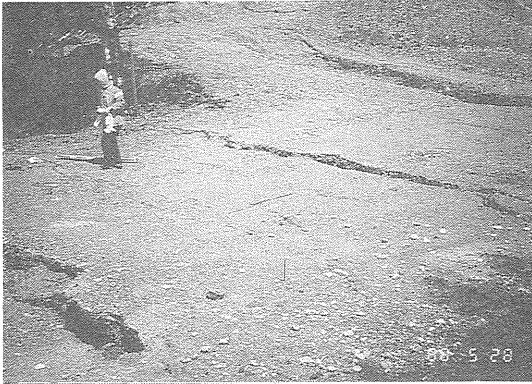
写真1 引張クラック ほぼ平行に3条のクラックが認められる(1988.5). 地すべりはクラックに直交して右上隅から左下隅に向かって移動している(向斜軸に平行).
