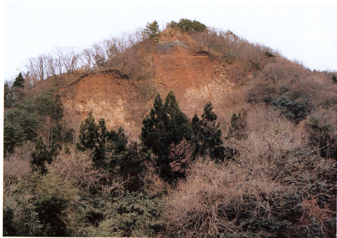
↑ 写真4 虎丸山：西三川砂金山中最大の砂金山。虎丸山中腹の肩の部分には、背後の海老根沢上流から引水した砂金用水の水を溜める虎丸山上堤があり、山裾には茶屋川から引水した下堤がある。放水時には二重の流となって谷川の土石を押し流すので、谷底の流し場を鉄砲場ともいった。
