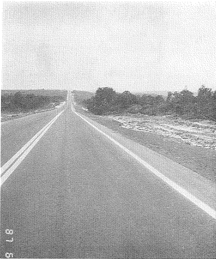
写真12 グラン・サバーナ入り口付近の舗装道路。
