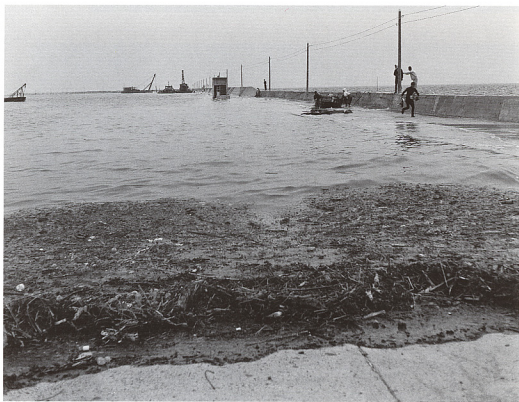
写真1 最高水位時の防波堤：御前崎港における最高水位は5月24日07時44分に366cmを記録し、東京湾中等潮位(T.P.)との差は201cmで、初動から4時間36分後に出現しています。防波堤に置いてある漁具を家族総出で、慌てて片付け、漁民たちの緊迫感がひしひしと伝わってきます。
