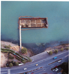
↑写真5 瀬田川川底の釜谷遺跡の発掘現場（発掘は縦50m横20mの範囲を鋼矢板で掘削して行われた）。
