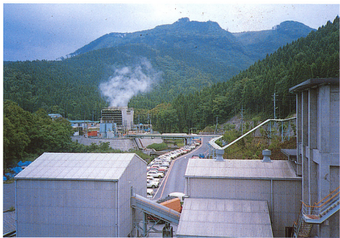
口絵II-3 鉦山風景：菱刈鉦床は加久藤カルデラ西側山地の麓にあって 鉦脈の生成が非常に若いために 鉦脈裂かは約60℃の温泉水でみだされている。そのため開発に当たっては温泉水のぬき取りが必要であり、冷却塔（中央左）の存在が一般鉦山と異なる外観を与えている。
