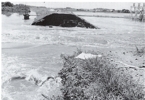
写真-14 10時20分頃 流れ込む洪水はもう止めようもありません。写真右上の水田は既に完全に冠水しています。堤防の決壊幅は最終的には約100mにも広がりました。
