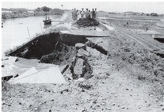
写真-9 9時50分頃 必死の水防作業も空しく 堤外地満杯の水の勢いには勝てず ついに堤防がドドッと音をたてて崩れ始めました。
