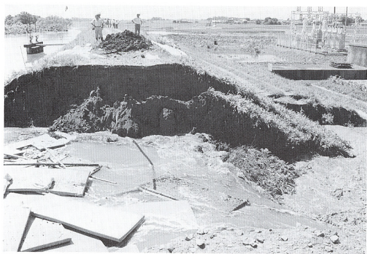
写真-11 押し寄せる洪水流によって、堤防の決壊幅は上流側（写真手前側）に どんどん広がっていきました。
