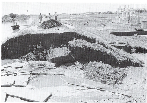
写真-10 9時57分 堤防が完全に決壊した決定的瞬間です。この写真によれば 堤防の決壊箇所比べて堤防下の漏水箇所が 下流側に若干ずれていることが明らかに読み取れます。
