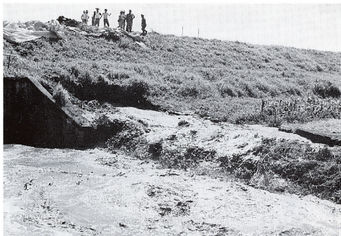
写真-6 漏水箇所はますます堤防本体へ拡大し 写真-5の看板も瞬時にして泥水の中に飲み込まれてしまいました。
