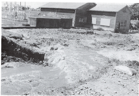
写真-12 堤内地へ一気に流れ下る浸水流。正面の建物は豊田機場。
