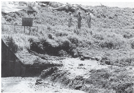
写真-5 漏水箇所はみるみるうちに拡大していきます。写真左上の看板に注目して下さい。
