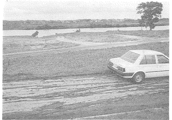
写真 8 千代橋下流右岸の氾濫による土砂の堆積。右が下流である。
