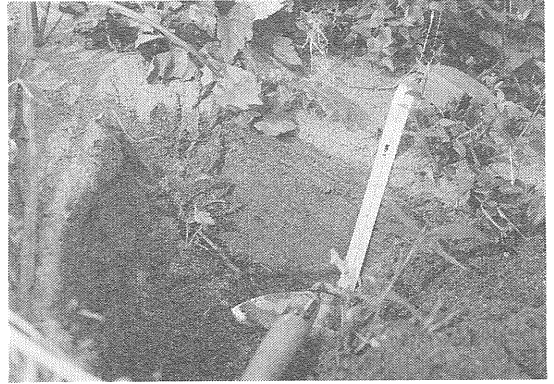
写真 6 千代橋右岸の堤に堆積した砂。砂は粗粒である。
