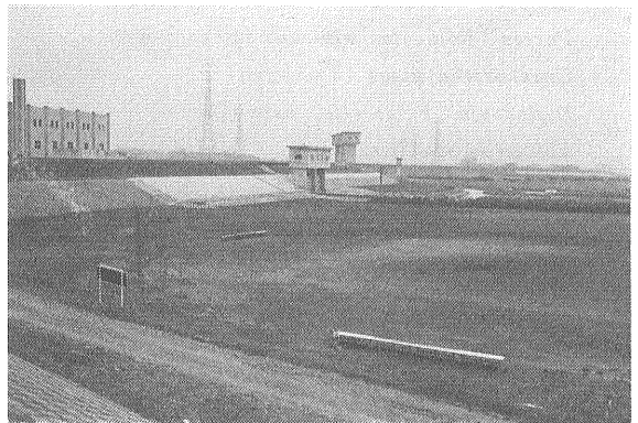
写真 4 水門 (遠景) が閉められた時に稼動する排水機 (左端の建物内) と樋門 (近景)
