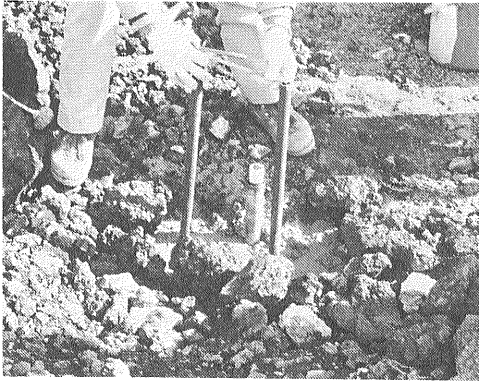
第21図 掘削作業終了後のDH-1坑口の様子。中央の短いパイプがケーシングパイプの先端で両側の2本は観測箱を支えるためのパイプ。1984年1月16日撮影。
