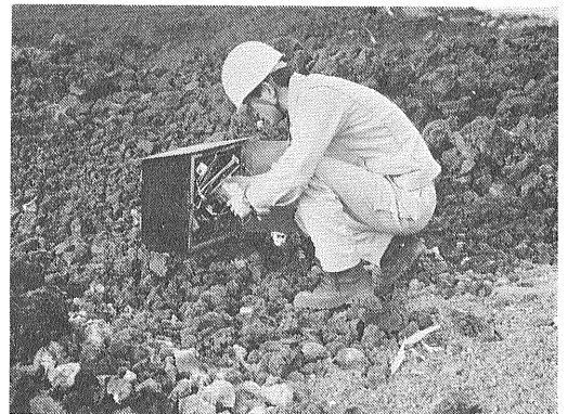
第23図 DH-1号井の口元に設けられた観測箱。黒色に塗装しましたが設置後1日で表面に灰色の昇華物が付くなど前途は多難のようです。1984年1月28日撮影。
