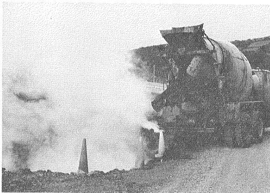
第5図 粟辺地区の電柱建設用穴への注水。ミキサー車から穴の中へ水を入れると途端に蒸気が立ち上がり中はしばらく地獄の様な状態となるが数分で乾燥してしまう。11月23日撮影。
