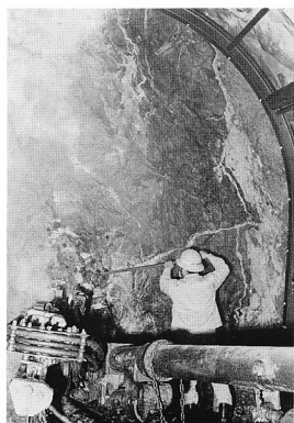
写真6 上坑口から1630mの切羽 砂質の変成岩とそれを貫くアブライト脈（右側）
