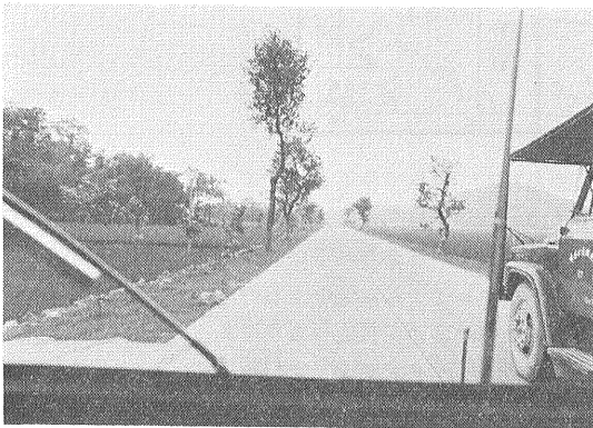
写真2 杭州から五部に向かうハイウエー 近傍に多い石灰岩は豊富なセメント資源である。アスファルト舗装道路の他に 日本では珍しいコンクリート舗装道路が普及している。モータリゼーションの進む中国では運河網に代わる大量陸上輸送網としてこのような舗装化が大規模に進められている。写真は右側通行中のトラックを左からジープが追い抜くところ。中国は車は右で人は左である。
