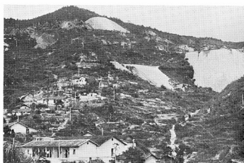
写真1 西華山鉍山寸景。最高800m付近の露頭部から230mLまで 緑の斜面に坑道を入れて採掘が続けられている。
