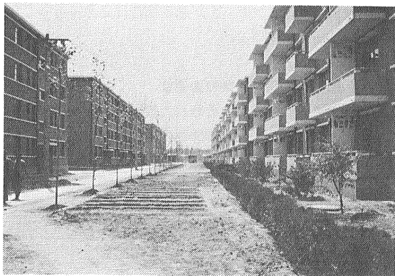
写真15 建設路紅星楼地区の復興アパート群
