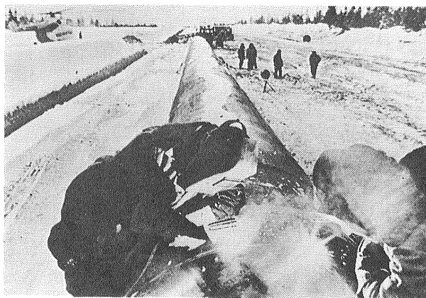
第3図 石油パイプライン “オーロラ”の敷設 が進む(《ソビエトグ ラフ》誌から)
