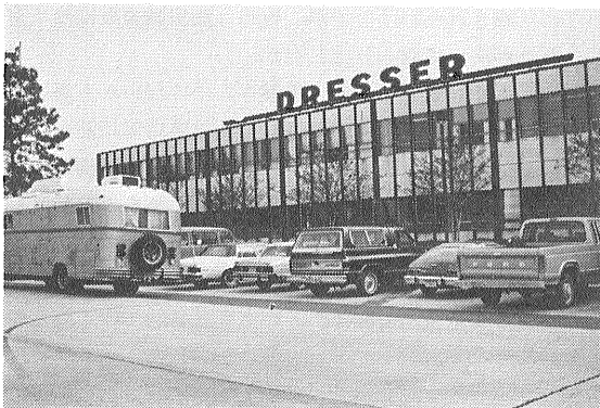
写真3 ドレッサー工業株式会社
