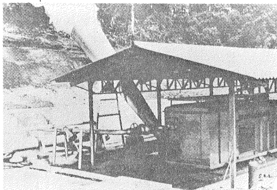
第4図 250 KW 地熱発電モノブロック
