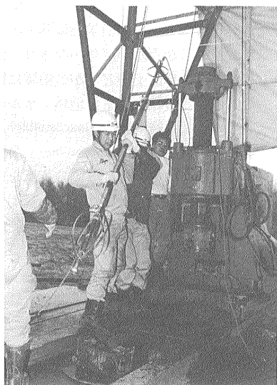
水圧破壊作業風景
