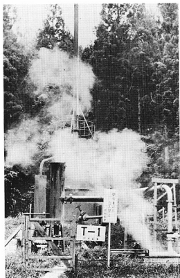
写真9 昭和49年大湯温泉地区で掘削された同和鉱業調査井 (T-1) 深度600m、孔底温度193℃で気水比は1:4である。
