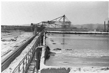
写真6 硝石を溶かす溶解槽。 鉱石を入れ温水を通す。
