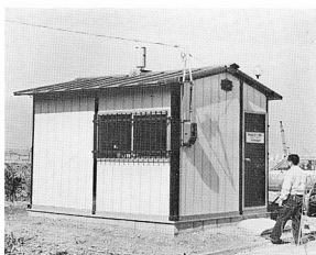
写真2 観測小屋 このなかに観測井及び観測機器が設置さ れている。屋根上の装置は雨量計
